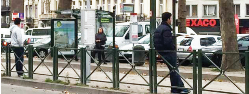
barrières "Croix de Saint André" présentes à différents endroits sur la berme centrale
