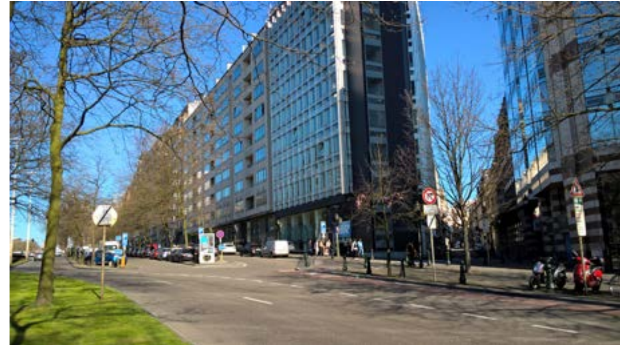
Bestaande situatie zicht op inrit van de zijweg
