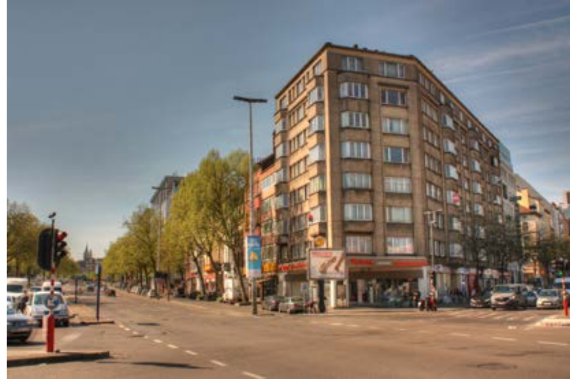
Bestaande toestand inrit van de zijweg
